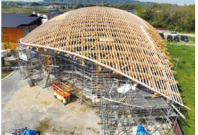
本造レシプロカル構造により20×30mの無柱大空間を実現する木材加工場を甲佐町に建大空間を実現する木材加工場を甲佐町に建大空間を実現する木材加工場を甲佐町に建大空間を実現する木材加工場を甲佐町に建大空間を実現する木炭レシプロカル構造により20×30mの無柱
